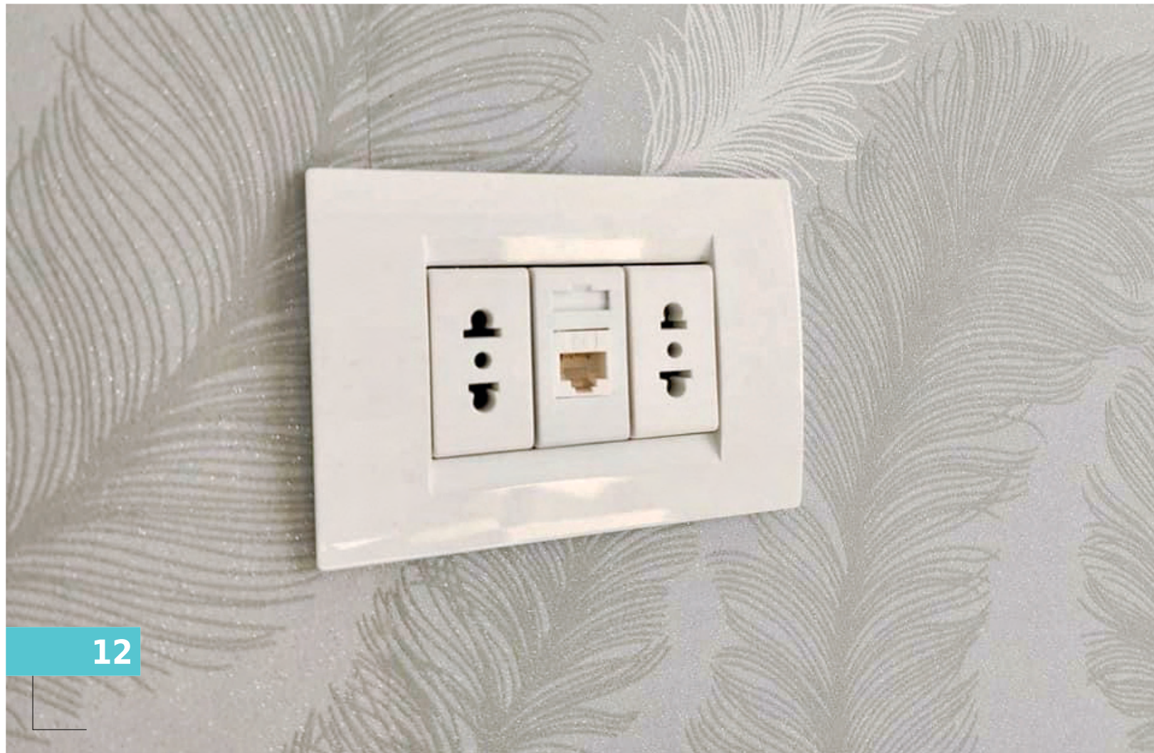
ստանդարտ / стандартные / standard 5422+5422 Վարդակ երկբևեռային x2 Розетка двухполюсная x2 Socket outlet x2
